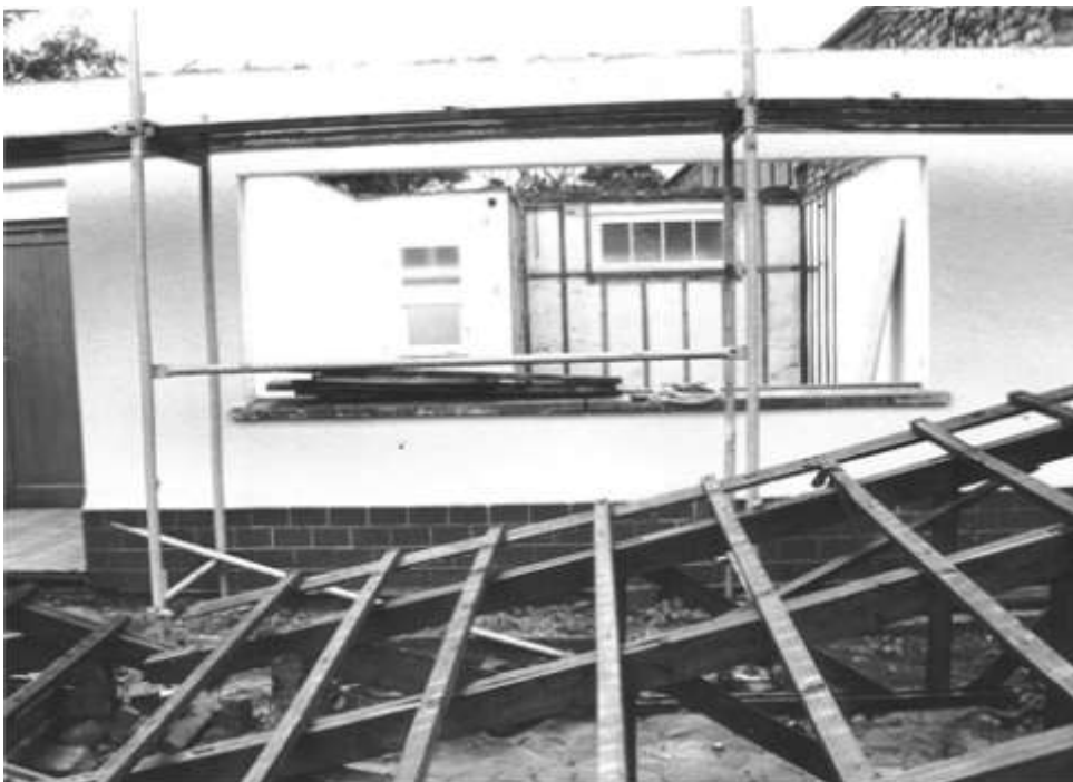
Das alte Dach und die Decken sind abgetragen.
