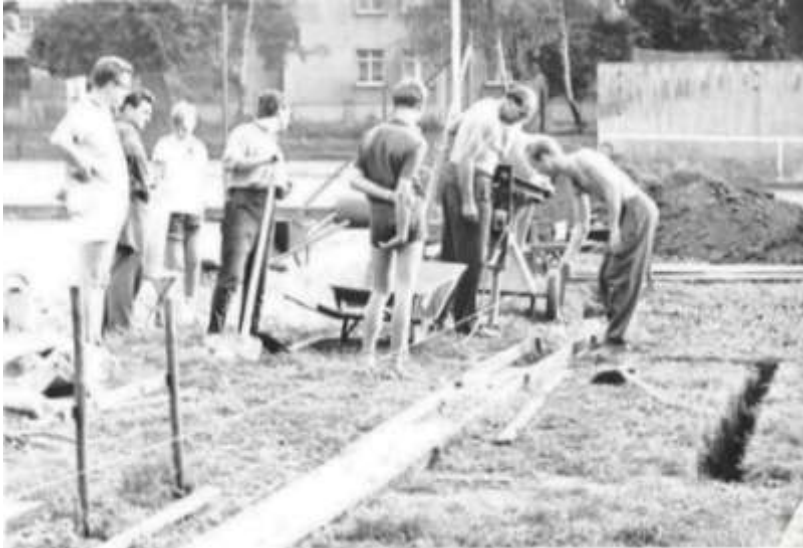
Beginn der Fundamentierungsarbeiten
