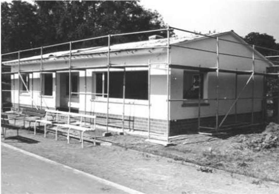
Einrüstung vor dem Umbau.
